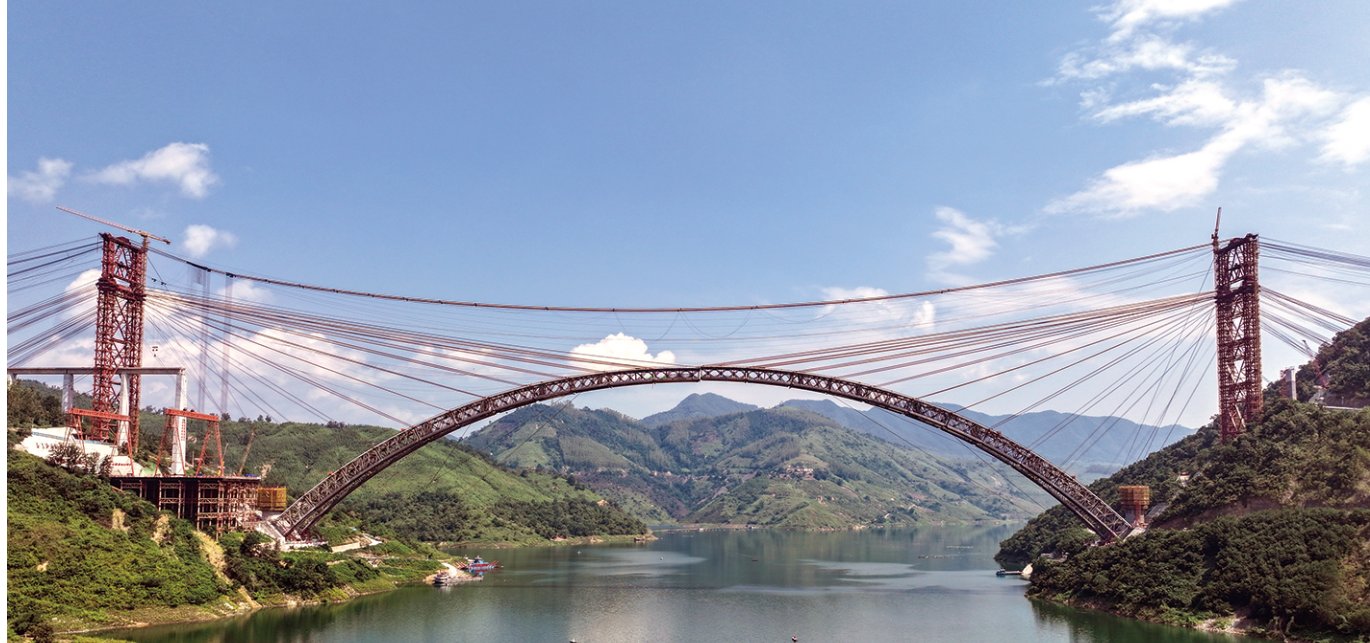
这是9月24日拍摄的即将完成主拱肋合龙的黄百铁路红水河大桥（无人机照片）。 9月29日，随着最后一节拱肋节段吊装到位，由中铁大桥局承建的贵州黄桶至广西百色铁路红水河铁路大桥拱肋顺利合龙。该桥位于黔桂交界处，横跨红水河。此次合龙标志着该桥主体施工取得关键性突破，为全线按期建成通车奠定坚实基础。 黄百铁路全长约315公里，设计时速160公里，为国家Ⅰ级单线电气化铁路，预计2028年建成通车。项目建成后，将进一步完善西部陆海新通道布局，构建我国西部地区通江达海便捷大通道。 新华社记者 刘续 摄
