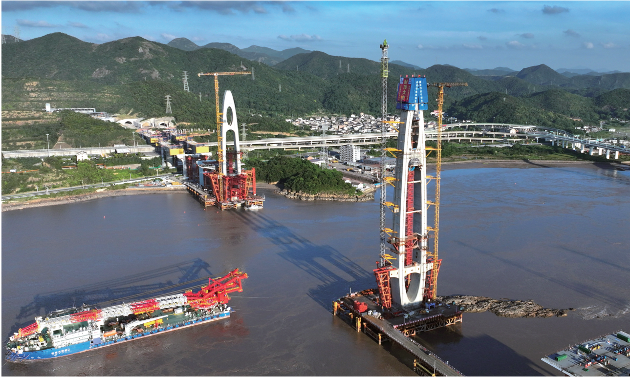
9月12日拍摄的南昌铁路富翅门公铁两用大桥20号主塔封顶施工现场（无人机照片）。富翅门公铁两用大桥连接庐山本岛与富翅岛，是南昌铁路的控制性工程之一。
