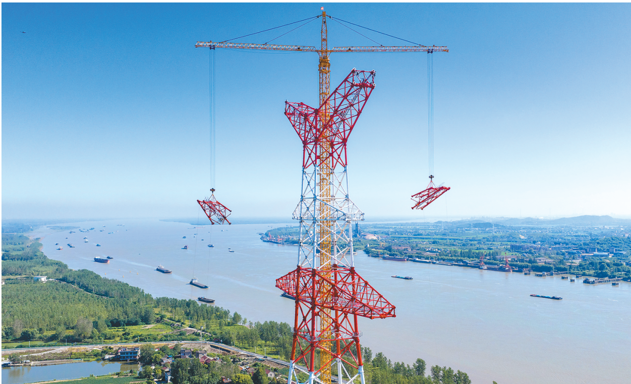
这是8月26日拍摄的甘特特高压长江大跨越输电塔封顶作业现场（无人机照片）。
