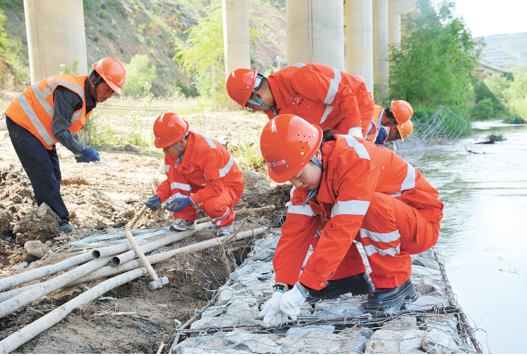
为了保证汛期道路安全畅通,礼县公路段筑牢防护墙加固安全网,做到防患于未然。图为工作人员在西汉水流域加固桥梁防护堤的情景。 本报通讯员 王喜平 摄
