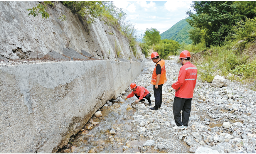
连日来，为了保证汛期国省干线道路行车安全，礼县公路段专业技术人员对辖区道路病害进行全面排查。
