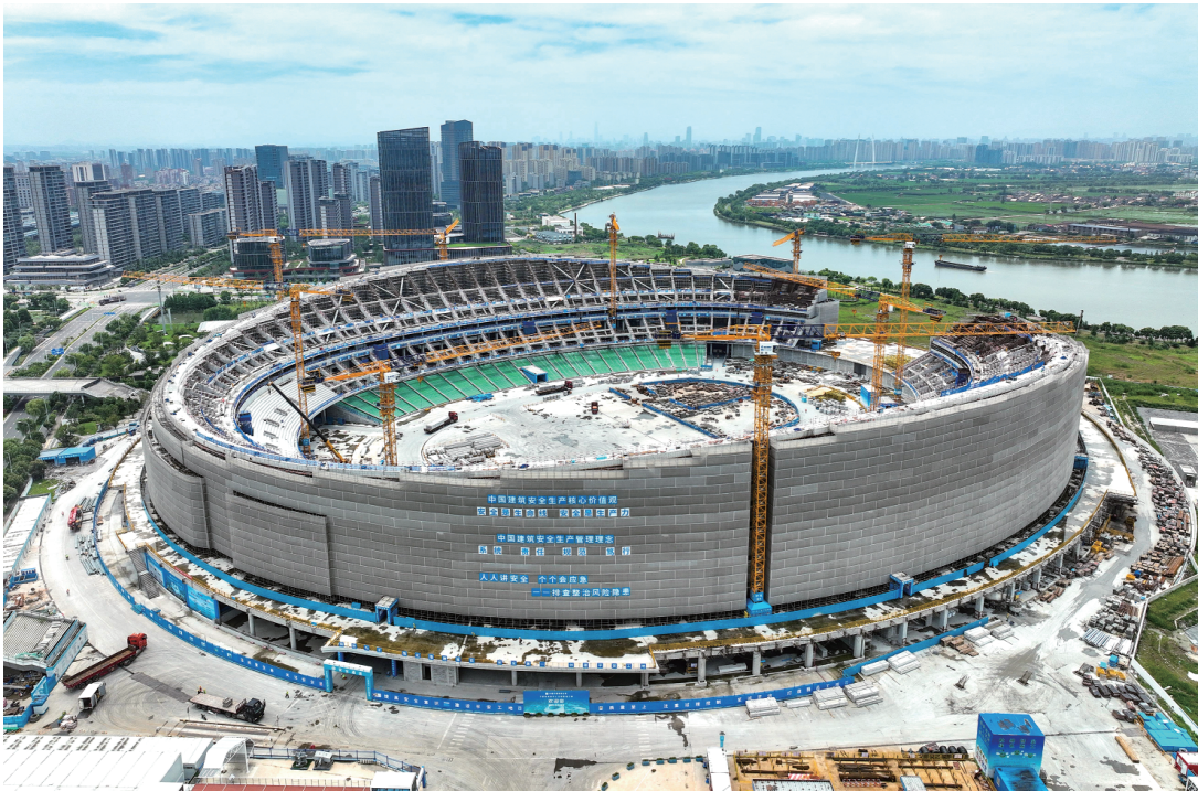
这是6月22日拍摄的宁波奥体中心体育场项目建设现场（无人机照片）。6月22日，由中建三局华东公司承建的宁波奥体中心体育场主体结构封顶，工程建设取得重要进展。宁波奥体中心体育场位于宁波市江北区，建成后将是一座拥有8.1万个座位、建筑面积约20万平方米的大型综合性体育场。 新华社记者 江汉 摄
