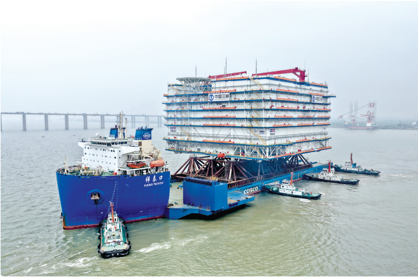
5月27日，总重约2.5万吨的超大规模海上接流站“海风之心”在江苏南通振华重装正式发运，将运往广东阳江海上风电场（无人机照片）。
