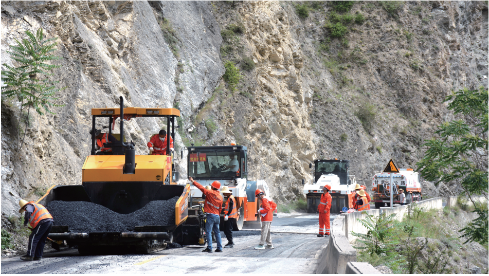
连日来，礼县公路段及时修补通往礼县大香山景区的公路，全力保障G247礼武公路朱雀一带道路安全畅通。
