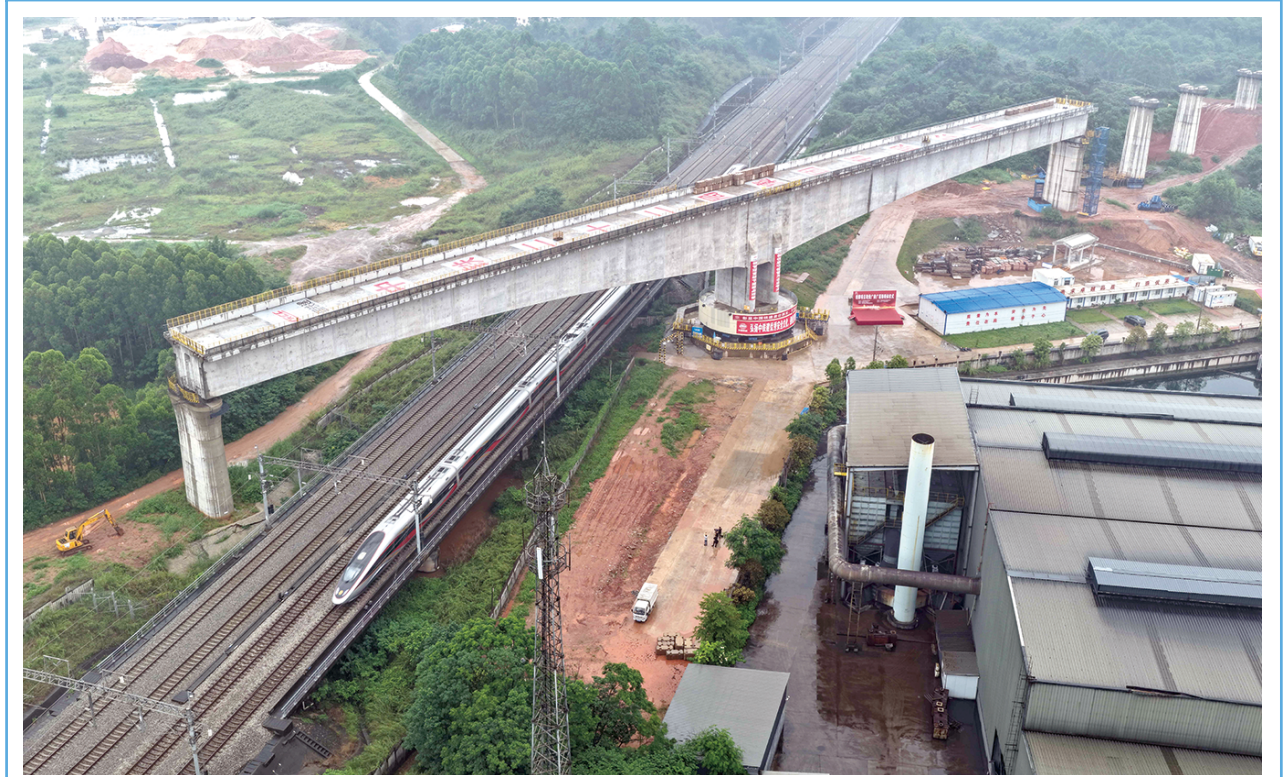
5月19日，高铁列车从转体成功的珠肇高铁西江特大桥转体连续梁下经过（无人机照片）。5月19日凌晨，中铁二十二局承建的珠肇高铁西江特大桥转体连续梁，在贵广、南广高铁干线上方成功平稳转体，为珠肇高铁西江特大桥后续箱梁架设和全线贯通奠定了基础。设计时速350公里的珠肇高铁连接珠海、江门、佛山和肇庆四个大湾区城市，主线接入建设中的广州新机场，是粤港澳大湾区城际铁路建设规划的重要组成部分。
