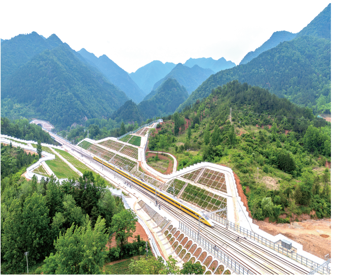
5月12日，DJ602次综合检测列车行驶在陕西省山阳县境内（无人机照片）。5月12日，DJ（动检）602次综合检测列车从西安东站平稳驶出，沿西十高铁正线穿越秦岭直达十堰东站，标志着西十高铁全线拉通试验正式启动，全线联调联试工作取得重要阶段性进展，为后续试运行和开通运营奠定坚实基础。西十高铁是国家“八纵八横”高铁网重要组成部分，该条高铁途经西安、商洛、十堰三市，接入已建成的武汉至十堰高铁。线路建成通车后，西安至十堰将实现1小时内到达，西安至武汉将实现2.5小时左右到达，对助力秦巴山区乡村振兴、推动沿线经济社会高质量发展具有重要意义。
