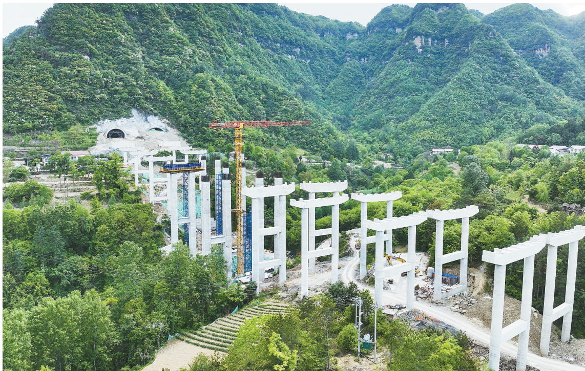
这是4月25日在四川省旺苍县境内拍摄的G5京昆高速汉广段扩容工程张河口1号隧道进口（无人机照片）。4月25日，由中铁五局承建的G5京昆高速汉中至广元段（四川境）扩容控制性工程张河口1号隧道实现大幅贯通，为全线按期通车奠定坚实基础。张河口1号隧道位于四川省旺苍县境内，为双向六车道高速公路隧道，左线长1223米，右线长1229米，最大埋深217.7米。京昆高速汉中至广元段扩容控制性工程是连接川陕的重要战略通道，项目建成后北向出川的公路通行能力将进一步提升。
