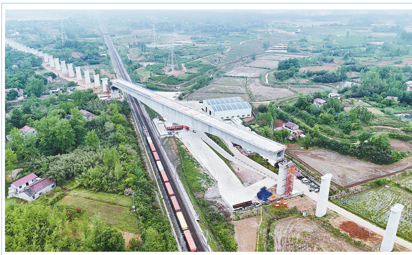
4月21日，在已完成转体的合武高铁跨宁西铁路万吨连续梁下方，列车在宁西铁路上行驶(无人机照片)。
