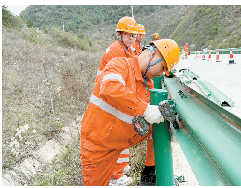
连日来,礼县公路段工作人员及时修复破损波形护栏杆,保证道路行车安全。 本报通讯员 王喜平 摄
