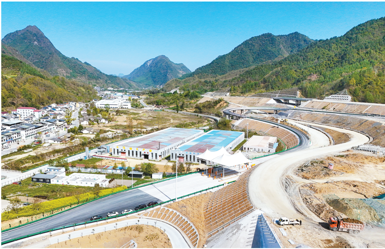
目前,S44康县至略阳高速公路康县东收费站土建、机电、房建等主体工程已全部完工,正全力推进交安设施安装、机电设备调试与服务区配套完善等工作,为4月底实现重点路段通车提供保障。图为康县东收费站建设现场。 本报通讯员 曾英 摄
