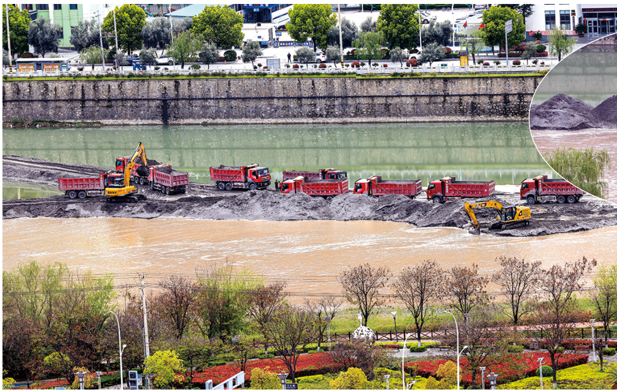
3月30日，在白龙江陇南市区段，工程机械正在进行河道清淤疏浚作业。眼下正值早春水利施工黄金期，当地有序推进白龙江河道清淤工程，提升河道蓄水排涝能力，改善水生态环境，保障河道水流通畅。 本报记者 冉创昌 摄
