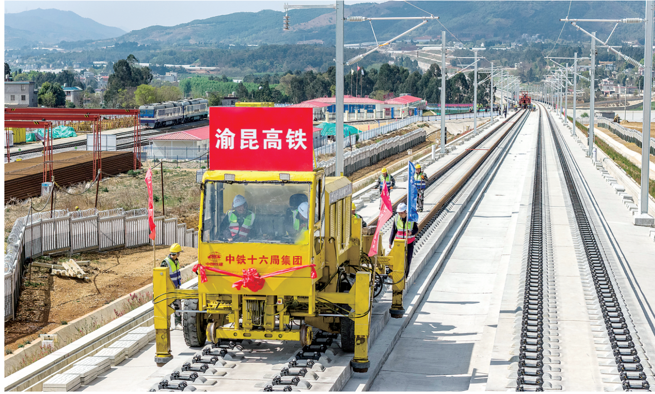
3月18日在云南省昆明市嵩明县拍摄的渝昆高铁施工现场（无人机照片）。
