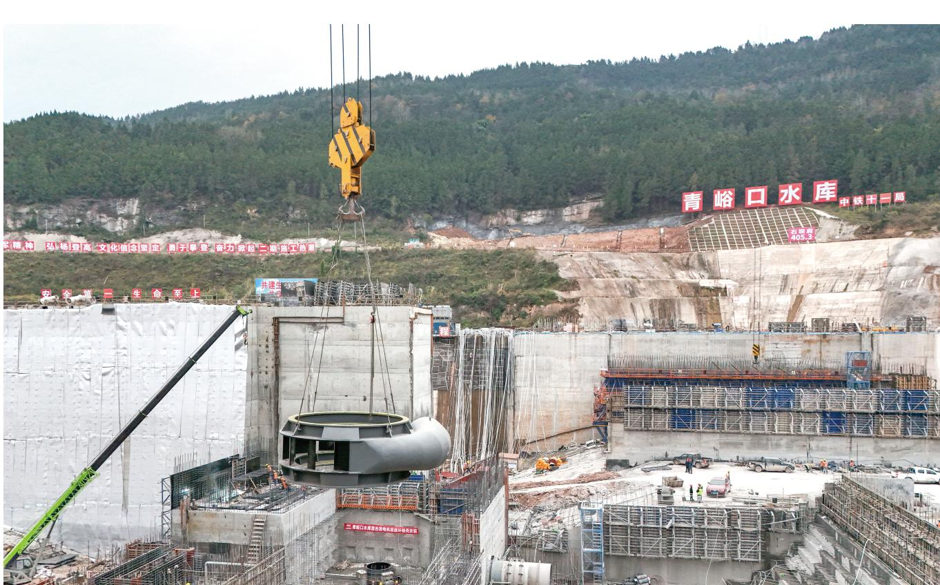
12月20日，在青峪口水库施工现场，工程机械在进行发电机组部件吊装作业（无人机照片）。
