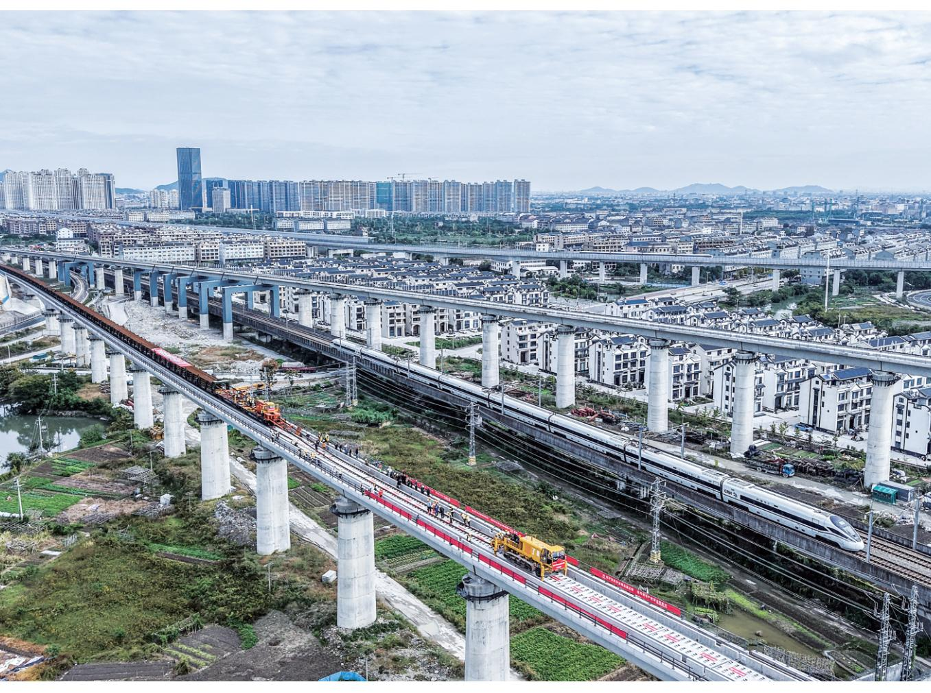
11月5日，在浙江省台州市杭台高铁温岭至玉环段施工现场，中铁十四局工作人员操作长轨牵引车进行铺轨作业（无人机照片）。
