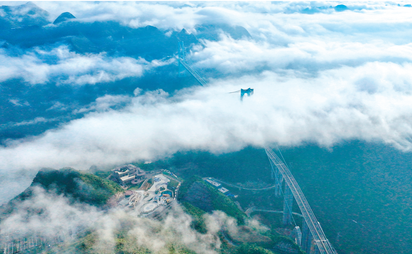
9月28日拍摄的贵州花江峡谷大桥（无人机照片）。9月28日，世界第一高桥——贵州花江峡谷大桥建成通车。花江峡谷大桥是贵州六枝至安龙高速公路的控制性工程，大桥全长2890米，主跨径1420米，是目前世界山区峡谷第一大跨度钢桁梁悬索桥；其桥面距水面垂直高度625米，是新的世界第一高桥。 新华社记者 刘 续 摄
