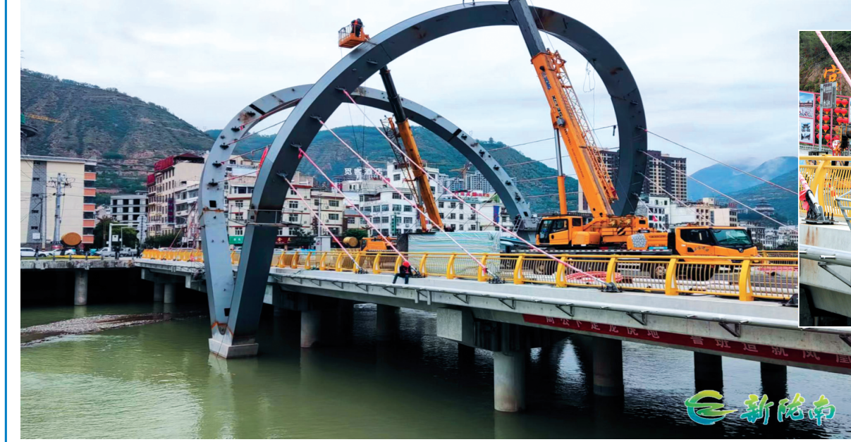
近日，宕昌官官鹅桥改造正在进行钢构架吊装焊接和亮化安装工作，预计工程于9月中旬竣工。 本报通讯员 刘治学 摄
