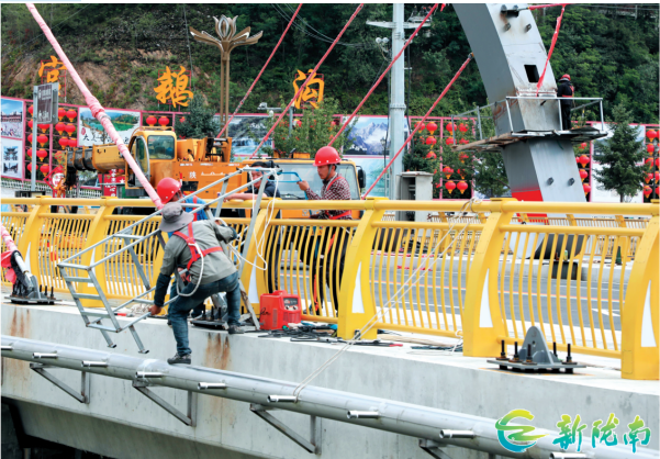
近日，宕昌官官鹅桥改造正在进行钢构架吊装焊接和亮化安装工作，预计工程于9月中旬竣工。 本报通讯员 刘治学 摄
