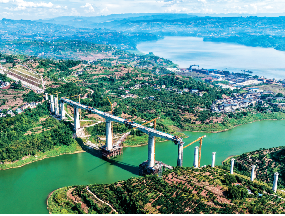
这是8月18日拍摄的渝万高铁渠溪河双线特大桥施工现场（无人机照片）。当日，由中国铁建大桥局承建的重庆至万州高速铁路（渝万高铁）渠溪河双线特大桥顺利合龙。渝万高铁渠溪河双线特大桥位于重庆市涪陵区珍溪镇，横跨长江支流渠溪河，全长约953米，是全线重难点工程。渝万高铁是我国“八纵八横”高铁网包（银）海、京昆通道的组成部分，正线全长251公里，设计时速350公里。
