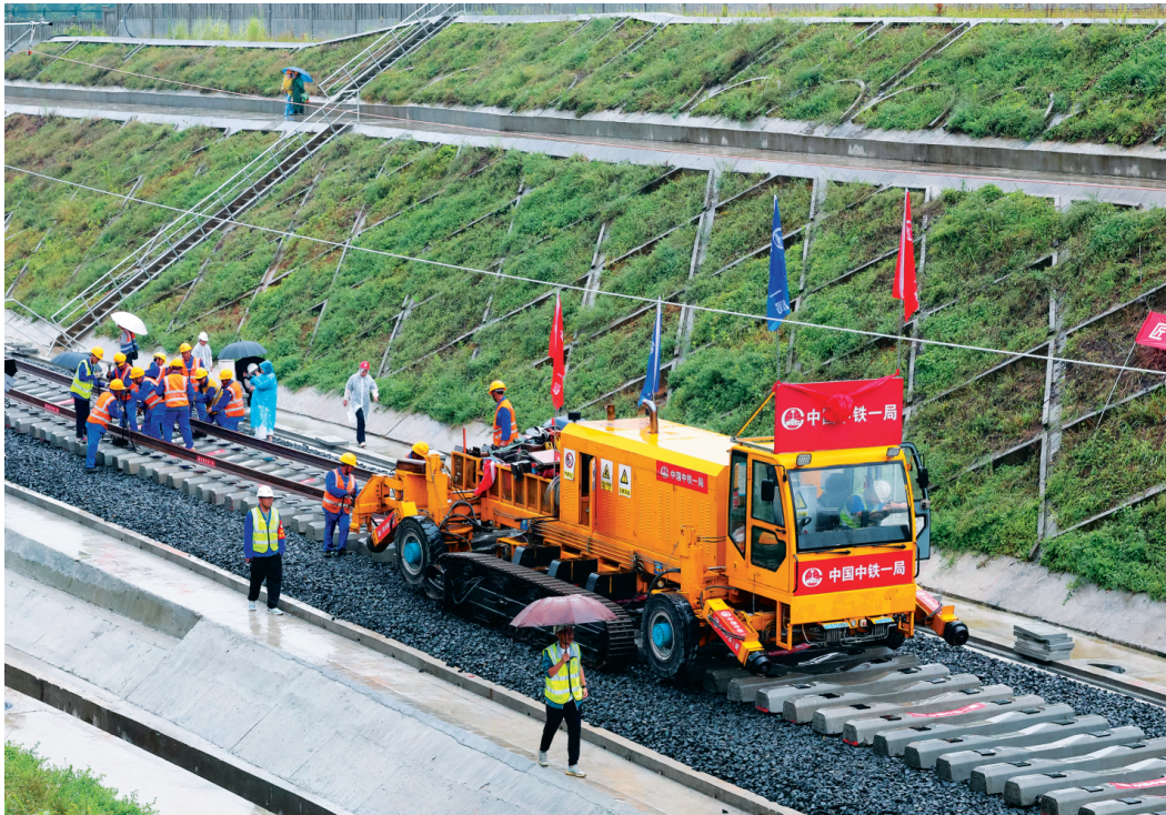
7月22日，中铁一局建设者在接轨处进行铺轨施工。 当日，随着最后一根500米长钢轨平铺铺设在位于贵州省盘州市的茶厅左线隧道路基上，盘兴高铁全线铺轨贯通。 盘(州)兴(义)高铁是贵州实现“市市通高铁”目标的最后一个项目，北起盘州站，南至兴义南站，全长约98公里，预计2025年底建成通车，建成后将实现贵阳至兴义2小时内直达，对促进区域经济发展具有重要意义。 新华社记者 刘 续 摄
