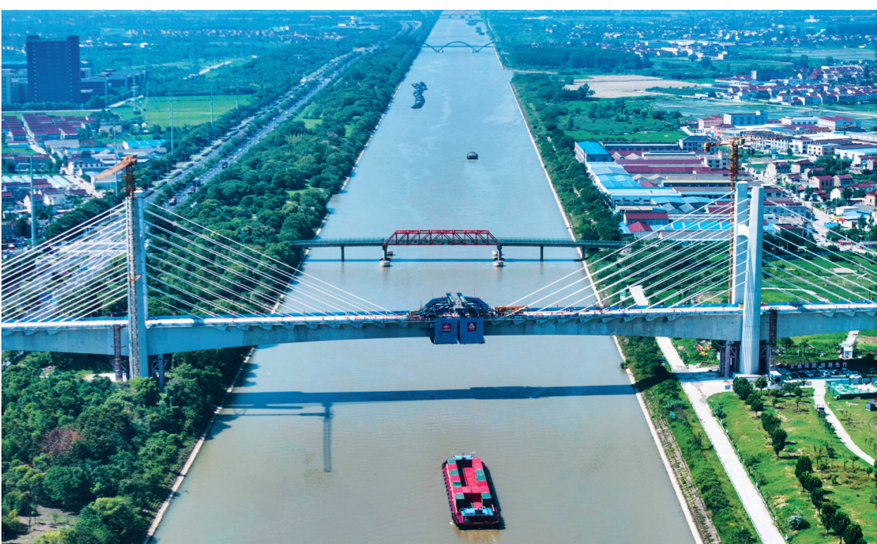
7月1日拍摄的沪渝蓉高铁通泰扬特大桥跨引江河斜拉桥（无人机照片）。 7月1日凌晨，由中国铁建大桥局承建的沪渝蓉高铁通泰扬特大桥跨引江河斜拉桥顺利合龙。 沪渝蓉高铁通泰扬特大桥全长172.9公里，跨越江苏南通、泰州、扬州市三市。此次合龙的跨引江河斜拉桥全长522.3米，主跨220米，是沪渝蓉高铁沪宁段首个实现合龙的斜拉桥。作为全线关键控制性节点工程，该桥的顺利合龙为沪渝蓉高铁通泰扬特大桥后续铺轨及全线贯通创造了有利条件。 沪渝蓉高铁是国家“八纵八横”高铁骨干通道之一，线路总长约2100公里，设计时速350公里。
