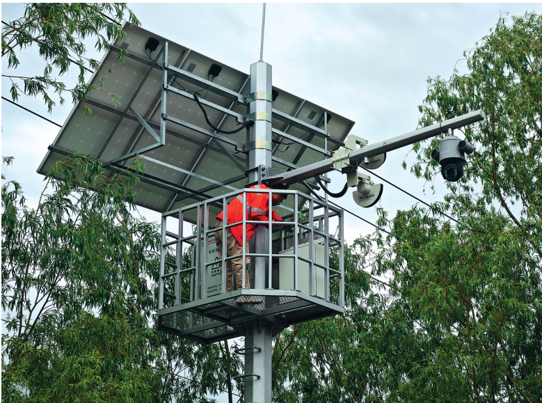
近日，礼县公路段对辖养的G247国道祁山交通量调查智能观测点开展全面保养维修工作。图为工作人员正在检修设备。
