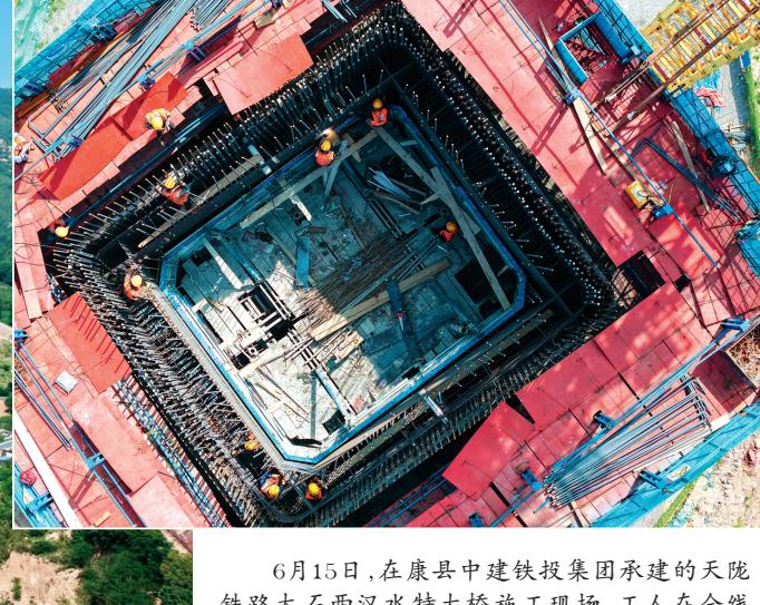
6月15日,在康县中建铁投集团承建的天陇铁路太石西汉水特大桥施工现场,工人在全线最高墩3号墩加紧施工。天陇铁路太石西汉水特大桥全长647.9米,其中3号墩墩高97.78米,为天陇铁路全线最高墩,墩身结构复杂,施工难度大,是天陇铁路全线重难点工程之一。
