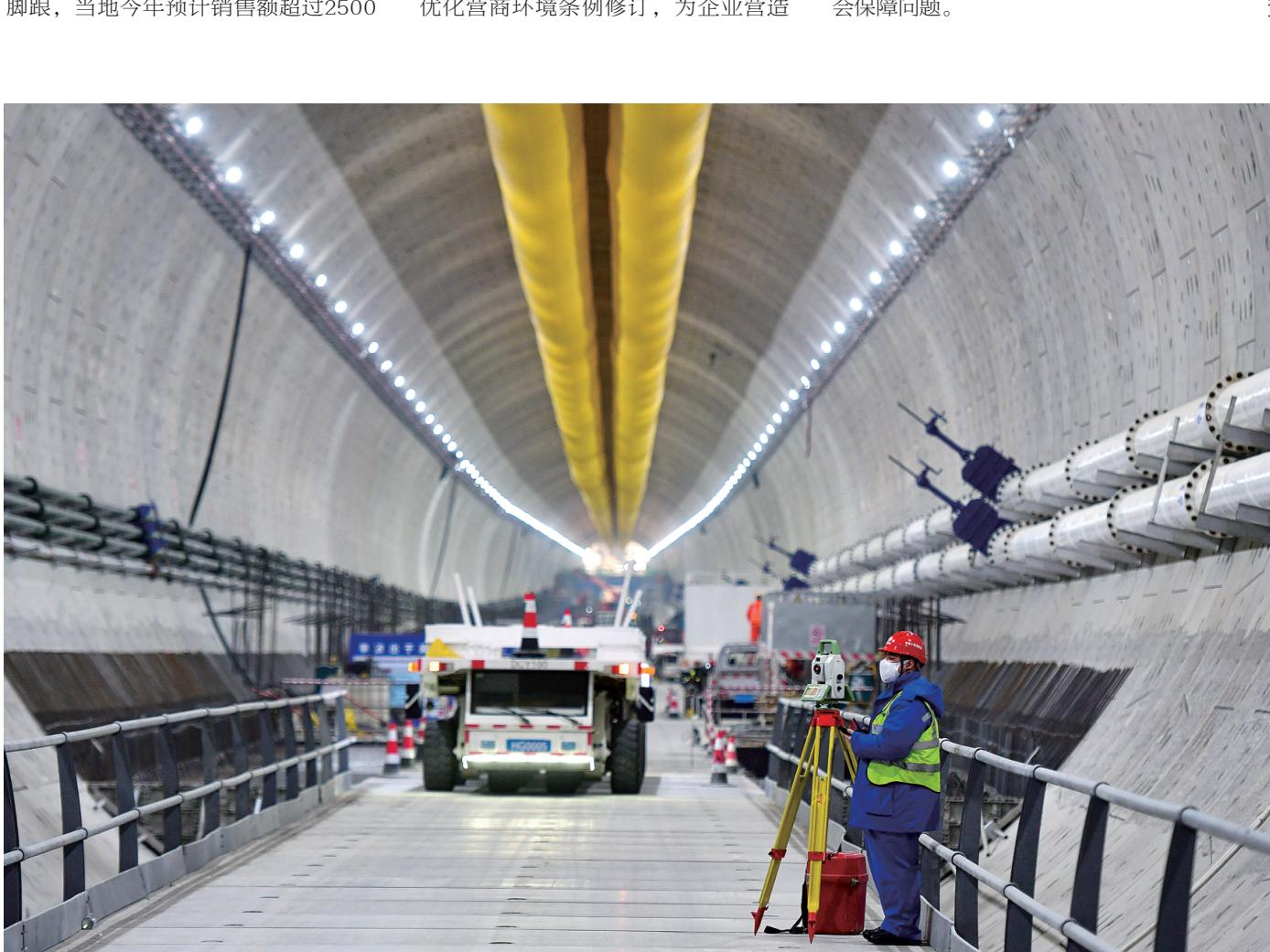
3月4日，中铁十四局建设者在济南市黄岗路穿黄隧道内施工。当日，山东省济南市黄岗路穿黄隧道进入黄河水域段施工，隧道盾构段已累计掘进1658米，开挖过半。济南市黄岗路穿黄隧道全长约5755米，其中盾构段长约3290米，盾构机开挖直径17.5米，是目前在建的世界最大直径水下盾构隧道。
