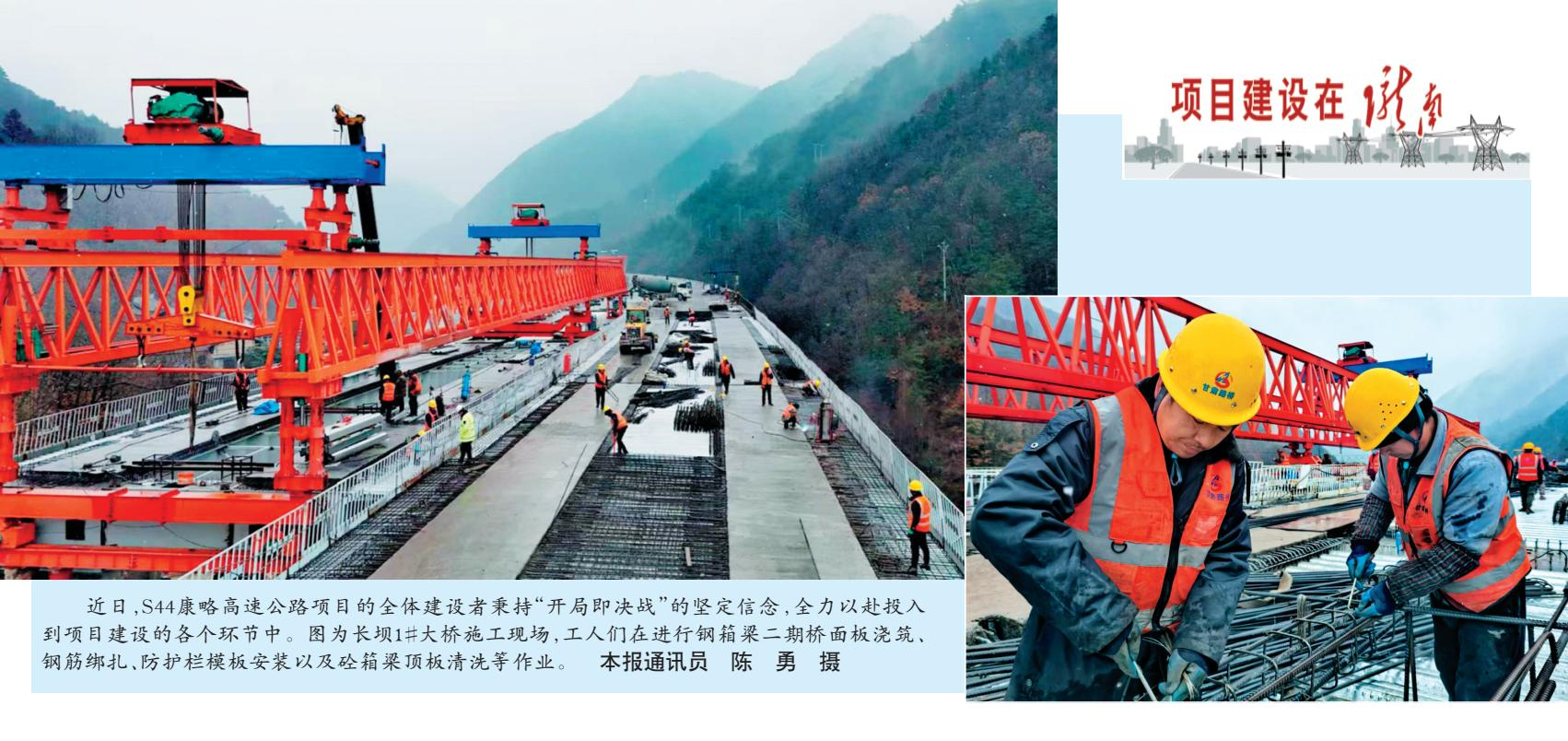
近日，S44康略高速公路项目的全体建设者秉持“开局即决战”的坚定信念，全力以赴投入到项目建设的各个环节中。图为长坝1#大桥施工现场，工人们正在进行钢箱梁二期桥面板浇筑、钢筋绑扎、防护栏模板安装以及砼箱梁顶板清洗等作业。本报通讯员 陈勇 摄
