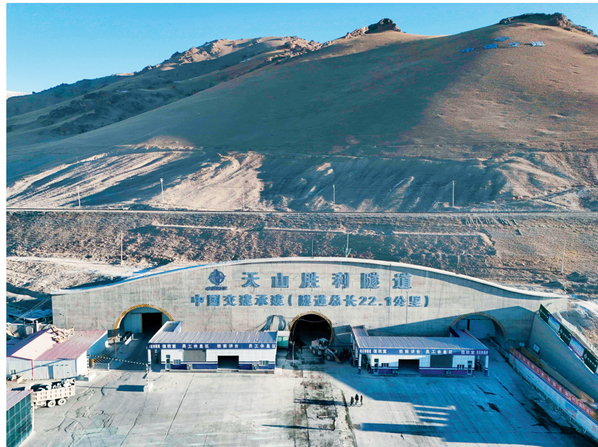
这是12月25日在新疆和静县拍摄的天山胜利隧道出口（无人机照片）。2024年12月30日11时许，世界最长高速公路隧道——天山胜利隧道全线贯通。天山胜利隧道是新疆乌尉（乌鲁木齐至尉犁）高速公路的“咽喉”工程，自2020年4月开工建设，历时近5年，先后数千名工人奋战在天山腹地。继秦岭终南山隧道之后，创下我国高速公路隧道建设的又一壮举。天山胜利隧道通车后，阻隔新疆南北的天山峻岭，穿越仅需20多分钟。
