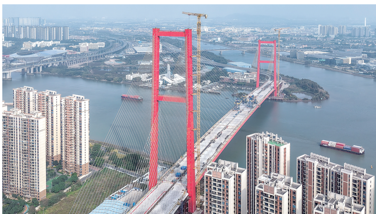
顺德大桥横跨容桂水道，连接顺德容桂与大良两个街道(12月24日摄，无人机照片)。当日，由中交路桥承建的顺德大桥顺利合龙。位于广东省佛山市顺德区的顺德大桥是主跨626米的超大跨径钢混组合索塔斜拉桥，索塔采用变截面H型塔柱，塔高分别为204米、151米。大桥建成后将有有效打通顺德融入粤港澳大湾区“一小时交通圈”的内部区域道路瓶颈。
