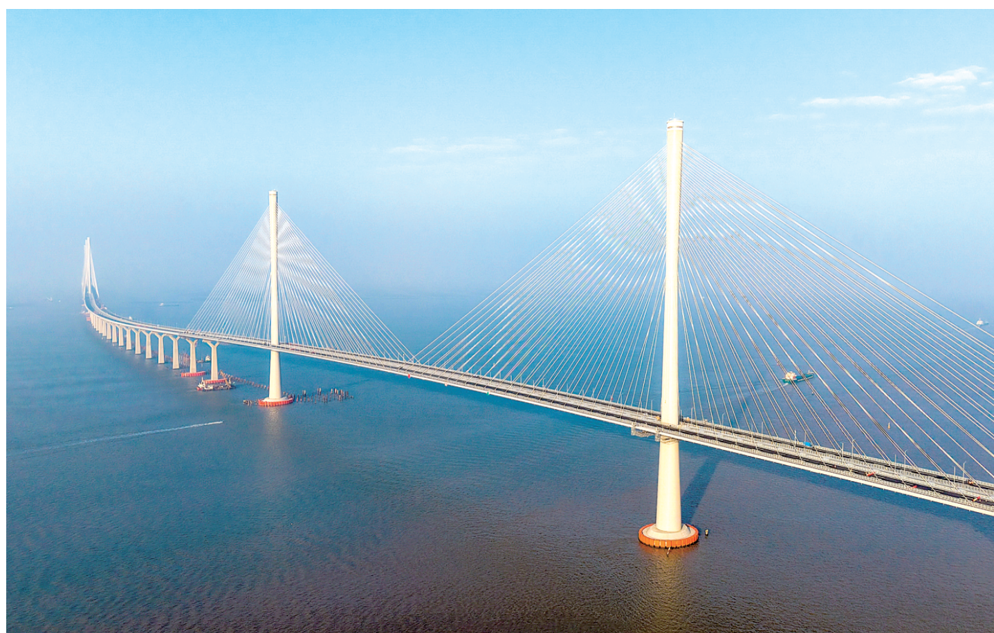
黄茅海跨海通道高栏港大桥(右侧两主塔)和黄茅海大桥(左侧三主塔)(12月7日摄,无人机照片)。历时四年建设的黄茅海跨海通道将于12月11日正式通车。黄茅海跨海通道起于广东珠海平沙镇,终于江门斗山镇,东接港珠澳大桥西延线鹤洲—高栏港高速,西接西部沿海高速,横跨珠江口崖门入海口黄茅海水域,线路全长约31公里,其中跨海段主要由高栏港大桥和黄茅海大桥组成。黄茅海跨海通道建成通车后,将与港珠澳大桥、深中通道、南沙大桥、虎门大桥共同组成粤港澳大湾区跨海跨江通道群。
