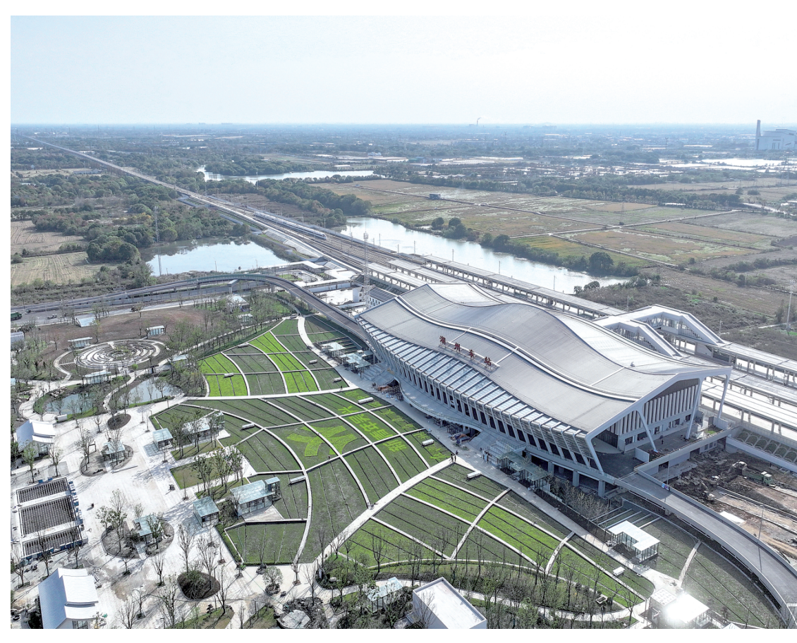
11月23日，沪苏湖高铁首趟试运行列车G55505次驶进湖州东站（无人机照片）。当日，首趟试运行的G55505次列车从上海虹桥站开出，沿着新建上海经苏州至湖州高速铁路驶向湖州站方向，进行列车运行图参数测试。这标志着沪苏湖高铁建设进入试运行阶段，全线开通运营进入倒计时。沪苏湖高铁自2020年6月开工建设，设计时速350公里。沪苏湖高铁建成运营后，将进一步优化上海铁路枢纽布局，完善区域路网布局，便利沿线人民群众出行。
