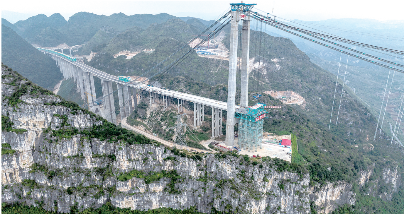
贵州交建集团所属桥梁集团工人准备吊装首件钢桁梁(11月4日摄，无人相机照片)。
