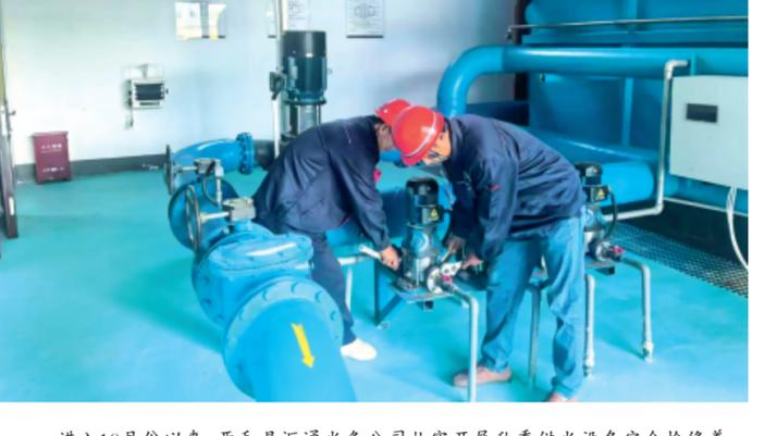
进入10月份以来，西和县汇通水务公司扎实开展秋季供水设备安全检修养护工作，组织人员对水源井排灌、配电设备、供水设施等进行全面细致的检查，以保障冬季低温天气下正常供水。
