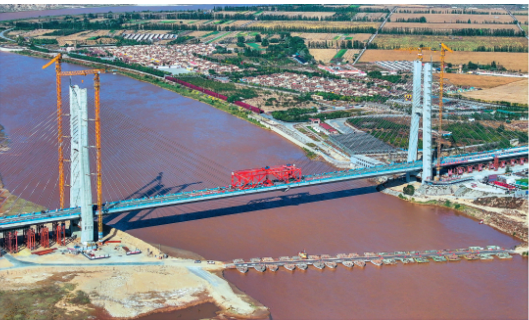
10月9日，包银高铁乌海黄河特大桥合龙贯通(无人机照片)。 当日，包银高铁乌海黄河特大桥顺利合龙贯通，为线路早日建成通车迈出坚实一步。包银高铁是我国“八纵八横”高速铁路网京兰通道的重要组成部分，设计时速250公里，是西北地区连接东北、华北地区的交通大动脉和经济大通道。 新华社记者 连振摄
