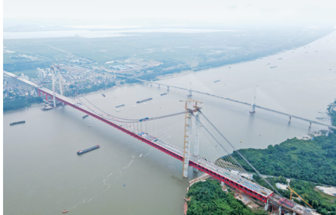
8月27日拍摄的G3(京台高速)铜陵长江公铁大桥(左)合龙现场(无人机照片)。当日，由中铁大桥局承建的G3(京台高速)铜陵长江公铁大桥主桥合龙。
