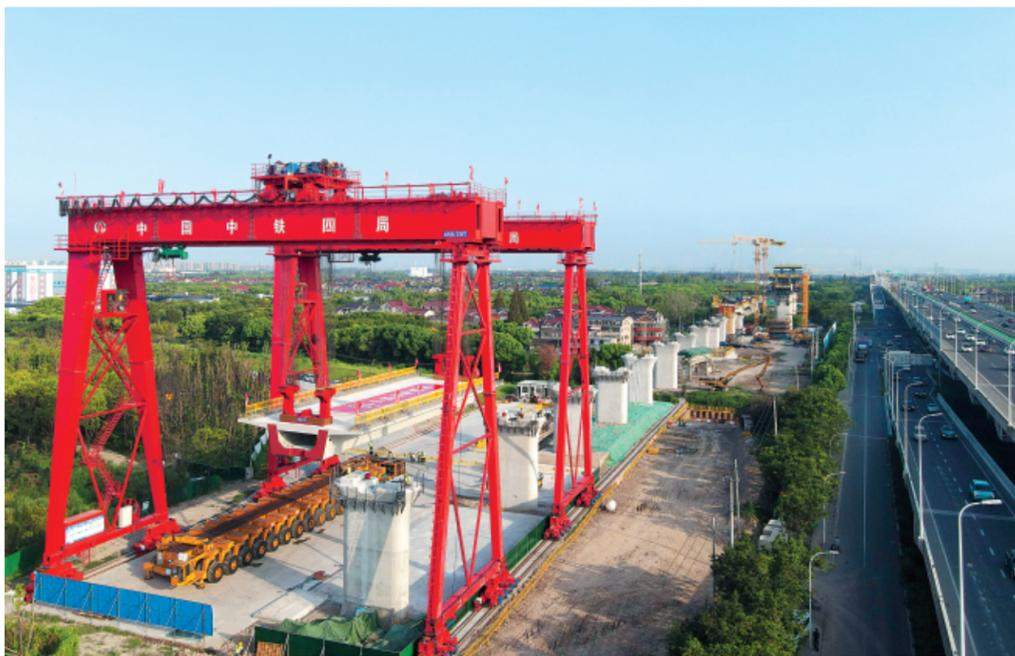
空中俯瞰沪渝蓉高铁上海段首幅箱梁架设施工现场（8月26日摄，无人机照片）。
