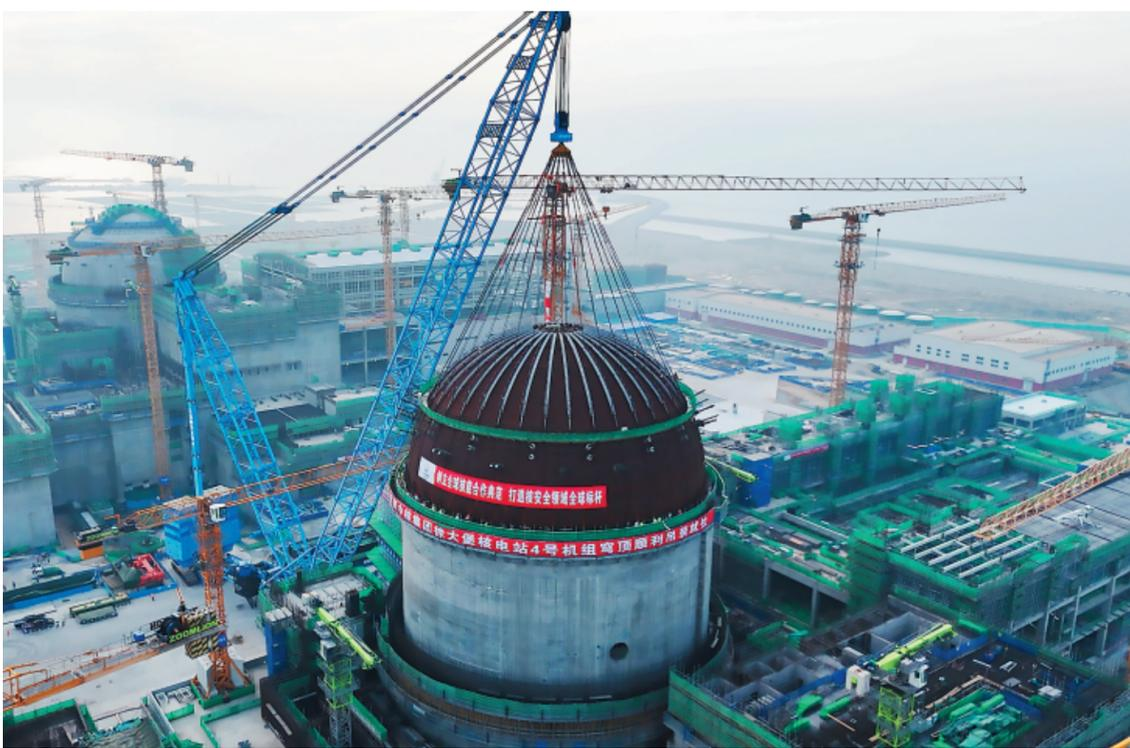
6月18日拍摄的徐大堡核电站4号机组穹顶吊装作业现场(无人机照片)。当日，位于辽宁省葫芦岛市的徐大堡核电站4号机组顺利实现穹顶吊装就位，为进一步推进工程建设奠定基础。
