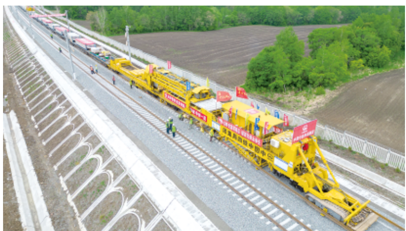
5月28日，中铁四局的工人在铁伊铁路二标段进行铺轨作业(无人机照片)。
