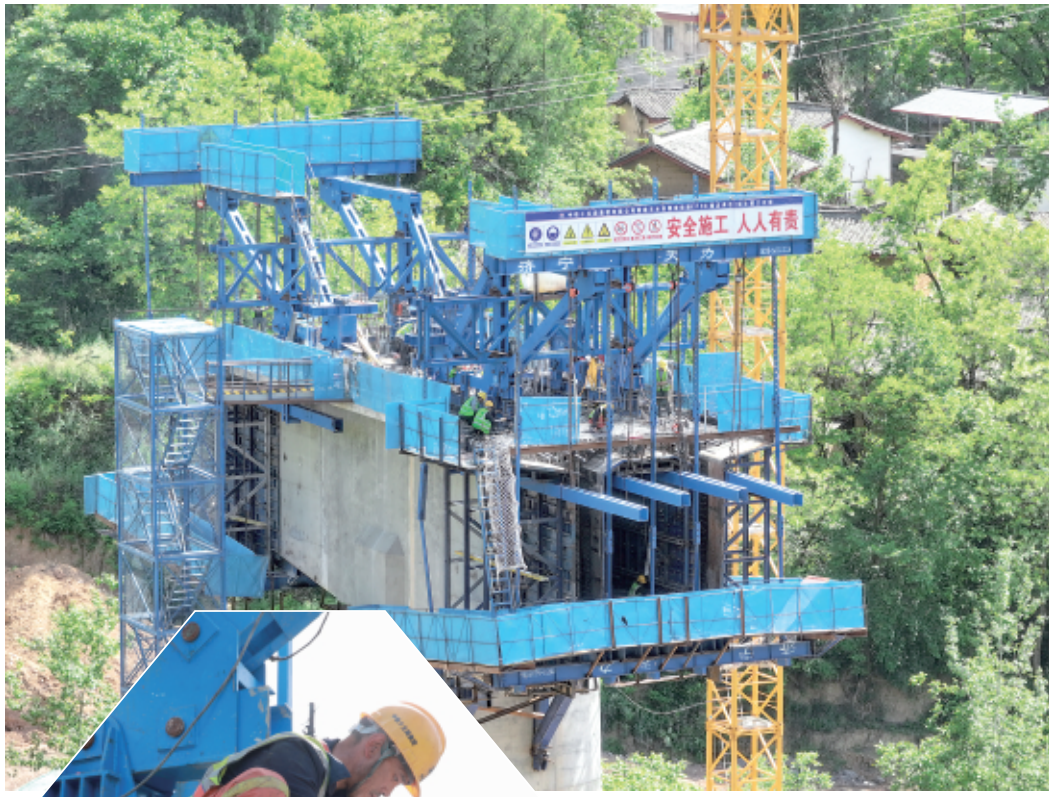
5月12日,由中铁十五局天陇铁路项目承建的康县望关镇庄子大桥施工现场,工人正在加紧建设。 本报记者 黄培军 摄
