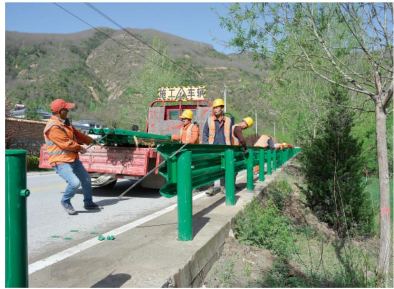
连日来，礼县公路段在国道316线开展交通安全设施精细化提升工程，将过去的防撞墩改造增设成三档(A级)刚性波形护栏，通过改造增设安全设施不仅保障了行车安全，还美化了路域环境。图为工人正在施工。 本报通讯员 王喜平 摄
