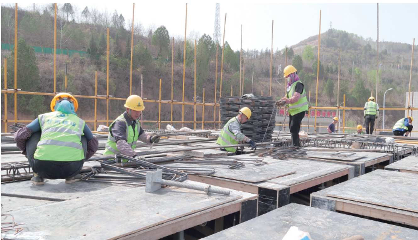
不负春日好时光,项目建设春潮涌。机器轰鸣、工人忙碌……当下,一个个重大项目在两当激战正酣。走进两当县智慧物流中心建设施工现场,施工人员按照各自分工,紧张忙碌地进行各项工作,呈现出一派热火朝天的建设场景。 本报通讯员 高浩东 摄
