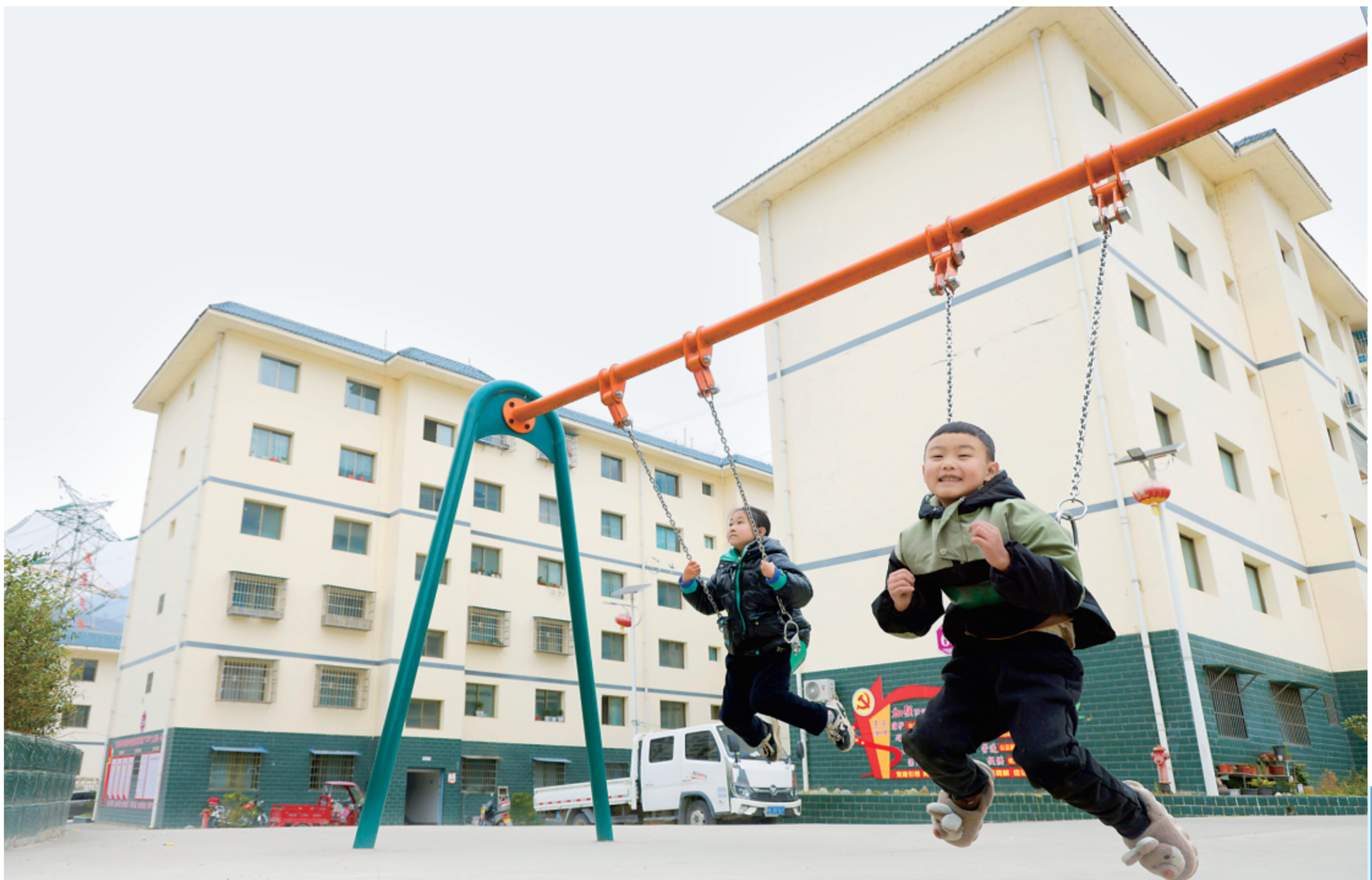
文县碧口镇早阳坝安置区。
