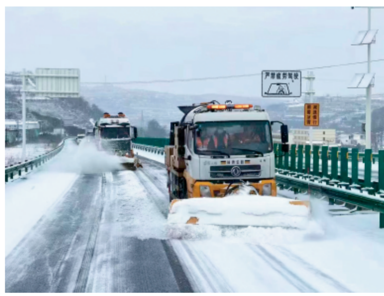
2月3日夜间断至4日，西和县境内迎来连续性降雪，西和公路段以雪为令，对G7011十天高速和国道567线糖养路段采取“人工+机械”同步进行，除雪设备“阶梯式”除雪的方式进行作业，帮助过往车辆安装防滑链，全力以赴保障糖养路段安全畅通。 本报通讯员 李文涛 摄
