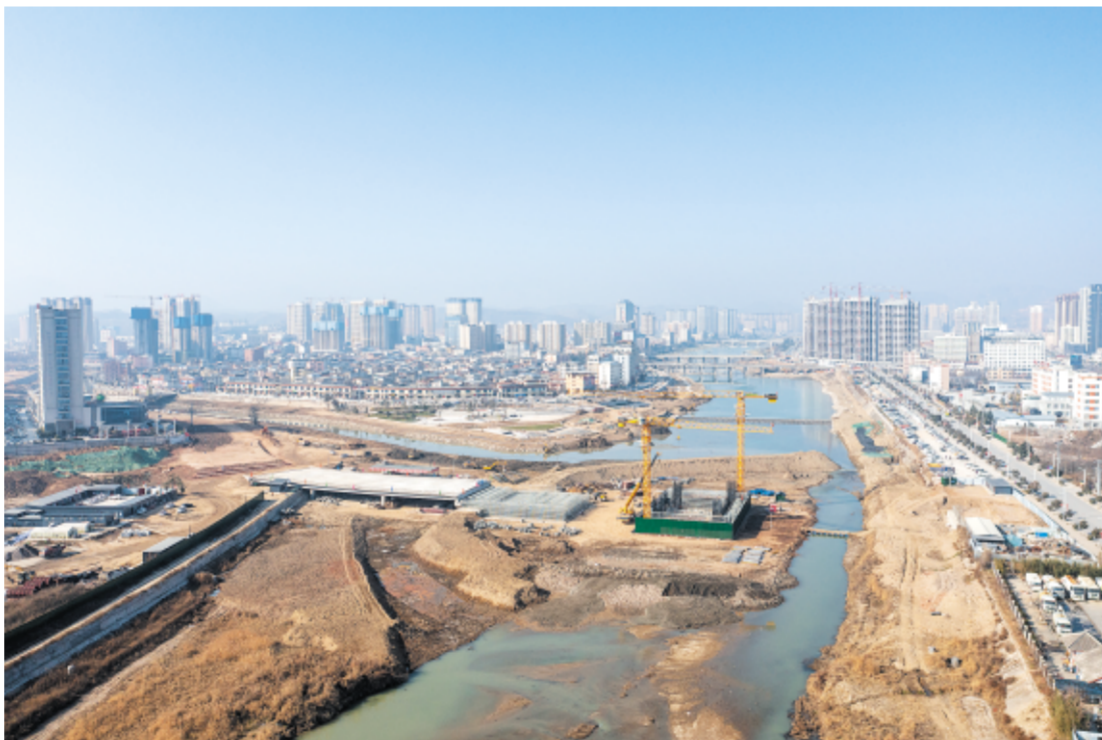
▲正在紧张施工中的成县成州大道青泥河大桥。据了解，成州大道建设项目总投资1.07亿元，全长8.3公里，是穿越县城东西的快速通道，建成后改善城区道路通行条件，有效缓解过境交通压力，提升城市品位。
