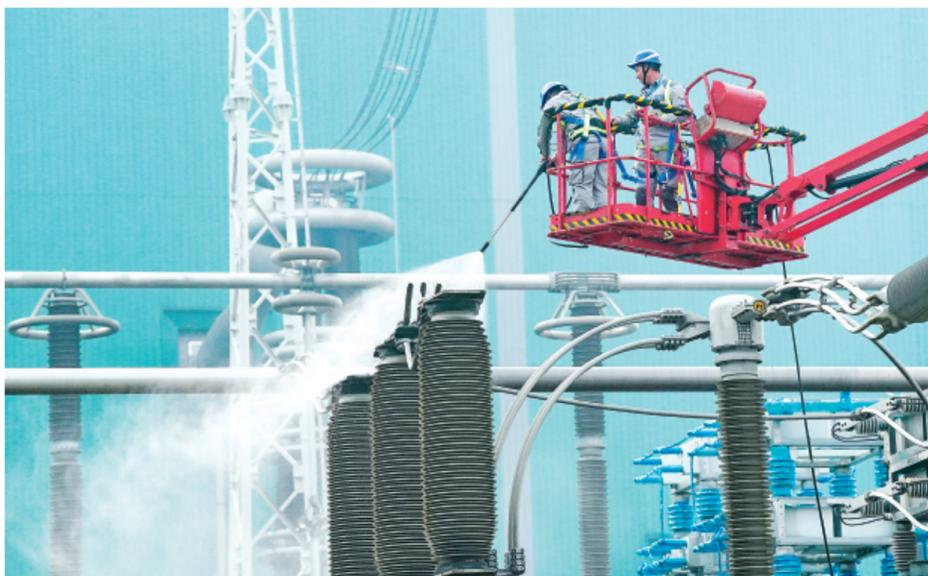
▲10月27日，国网安徽电力检修人员对古泉换流站设备进行检修、维护。10月24日起，昌吉-古泉±1100千伏特高压直流输电线路的受端站——安徽宣城古泉换流站迎来为期7天“体检”。国网安徽电力组织800多名电力检修人员对古泉换流站进行集中检修，有序开展41个作业面共计5200余项工作，为电网的安全稳定运行打下坚实基础。昌吉-古泉±1100千伏特高压直流输电工程起于新疆昌吉换流站，止于安徽古泉换流站，是目前世界上电压等级最高、输送距离最远、输送容量最大的输电工程。
