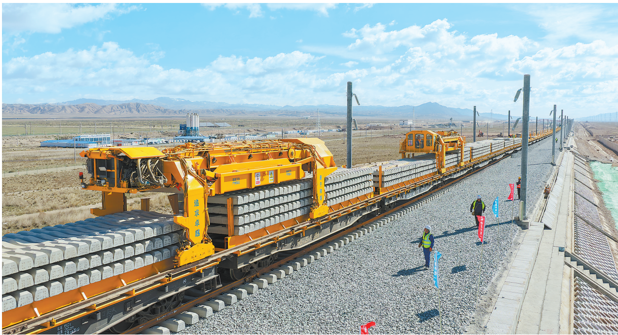
兰张高铁武威至张掖段全面进入铺轨阶段。
