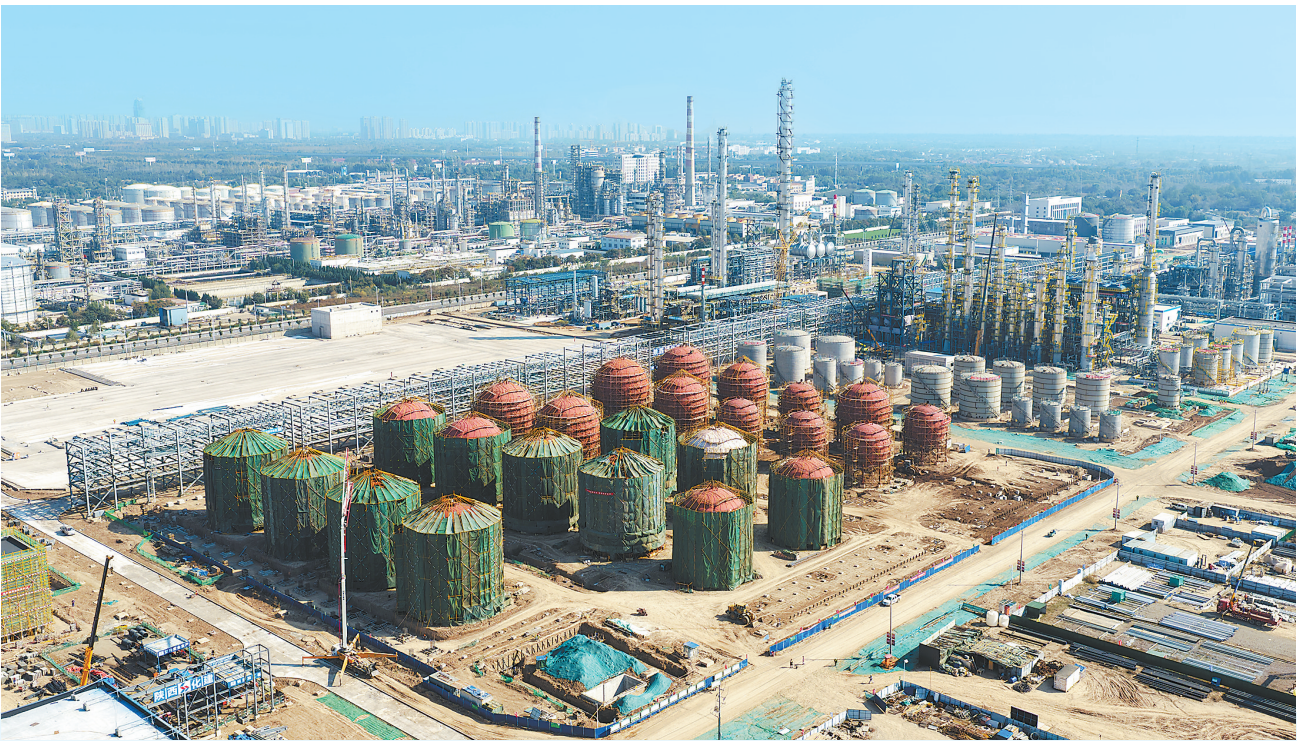
10月8日,在庆阳市西峰区工业园区内,庆阳同欣50万吨/年轻烃深加工项目正在加紧建设。
