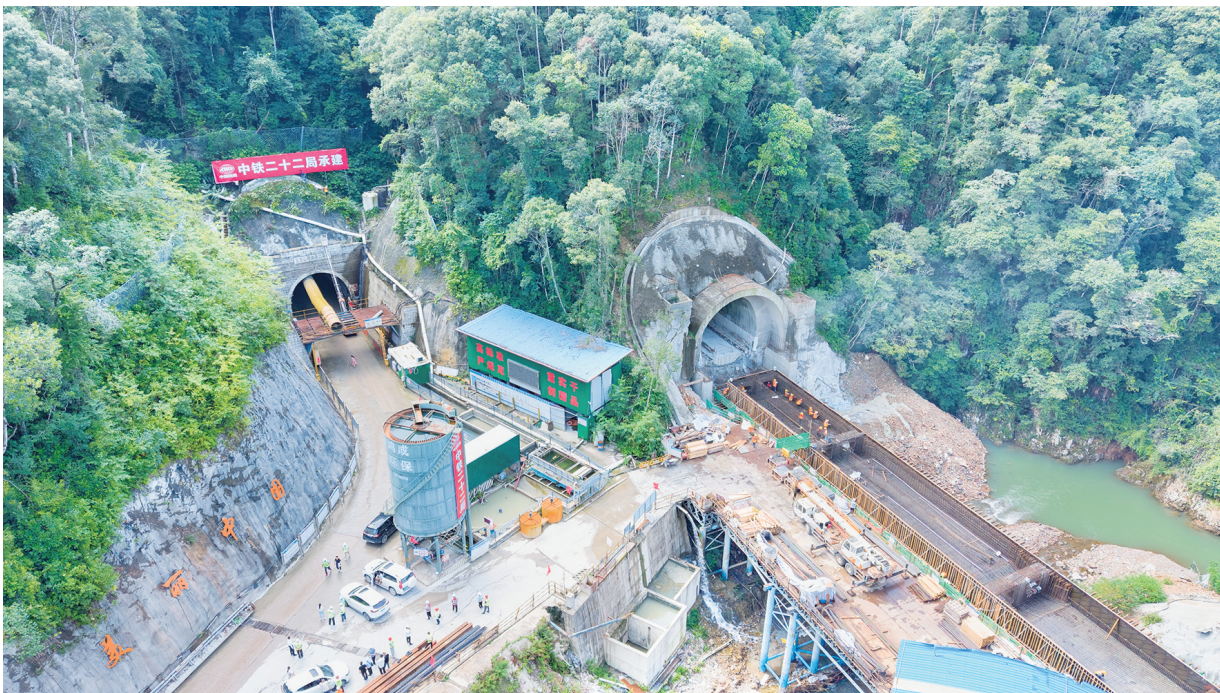
9月24日,由中铁二十二局和中铁十五局联合修建的江西瑞金至广东梅州铁路(瑞梅铁路)三百山隧道顺利贯通,标志着瑞梅铁路84座隧道全部贯通。图为项目施工现场。 许侨慰
