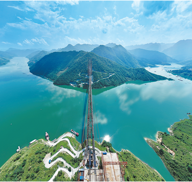
9月29日，随着最后一节拱肋节段吊装到位，贵州黄桶至广西百色铁路红水河铁路大桥拱肋顺利合龙。
