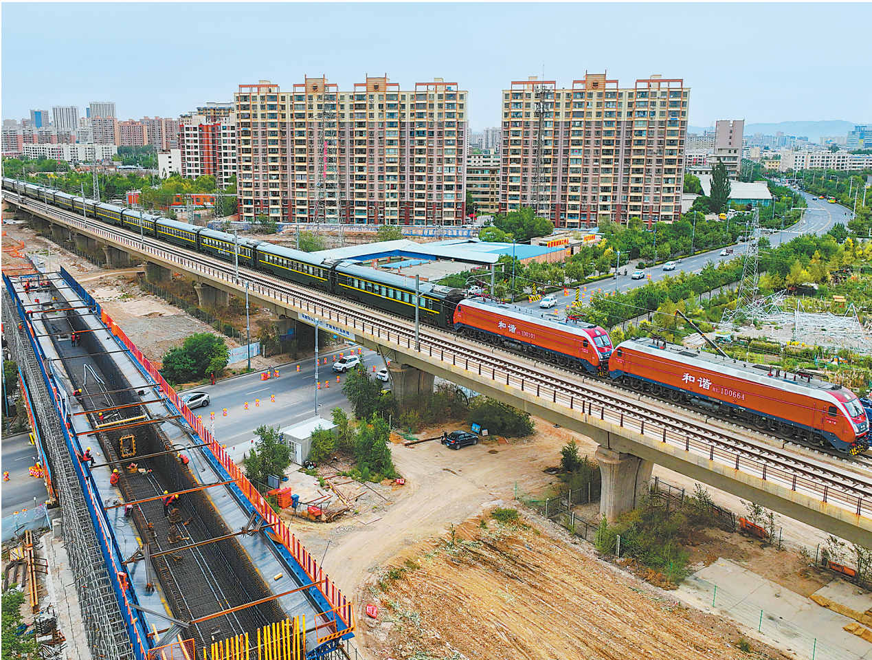
9月27日,张掖市甘州区境内兰张高铁三四线施工现场。
